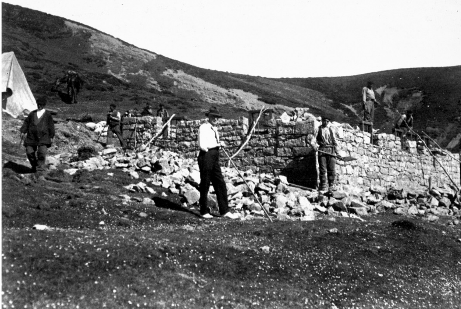
Construcción del Refugio de Igaratza. Año 1928
